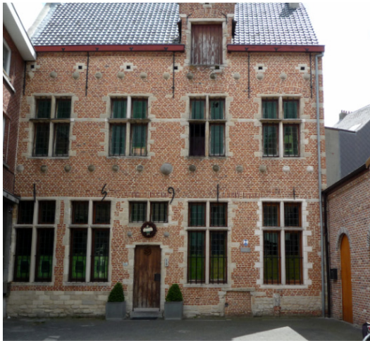
Het gerestaureerde kolveniershuis te Mechelen aan de Sint-Jacobsstraat
