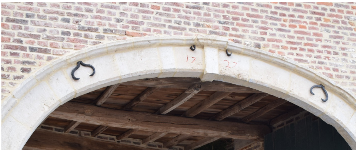
Na de restauratie
