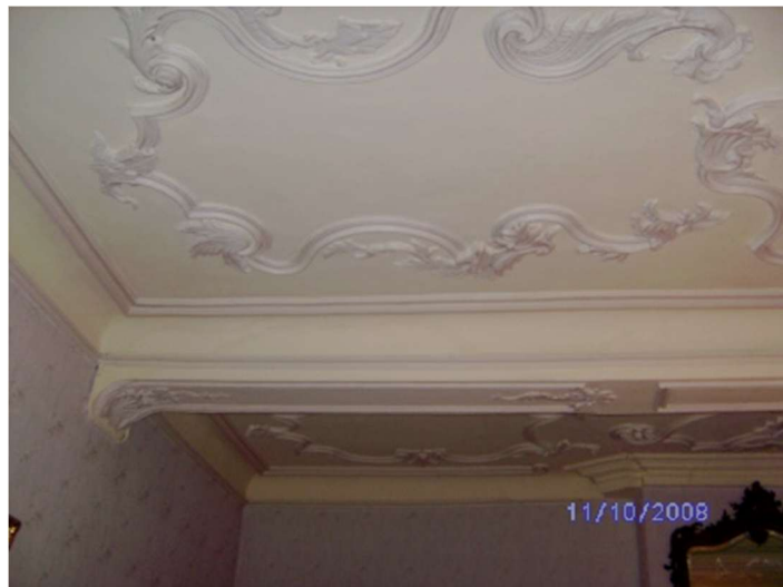
Plafond-stucwerk (18de eeuw)
