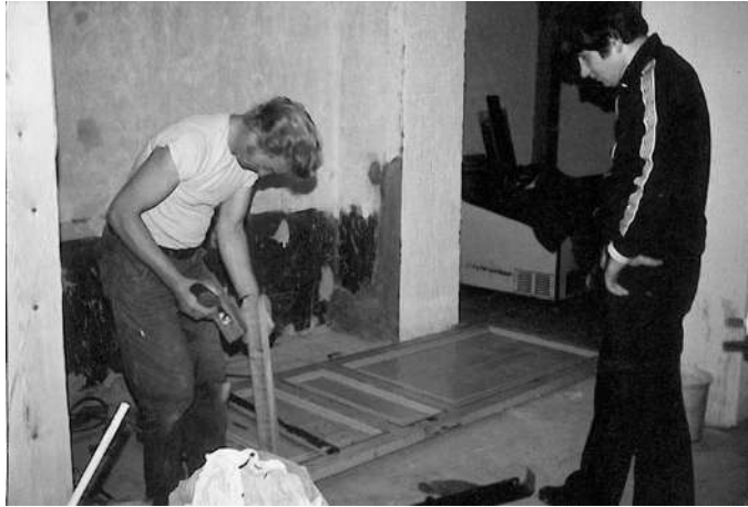
Figuur 13: Verbouwing: Marcel aan het werk
