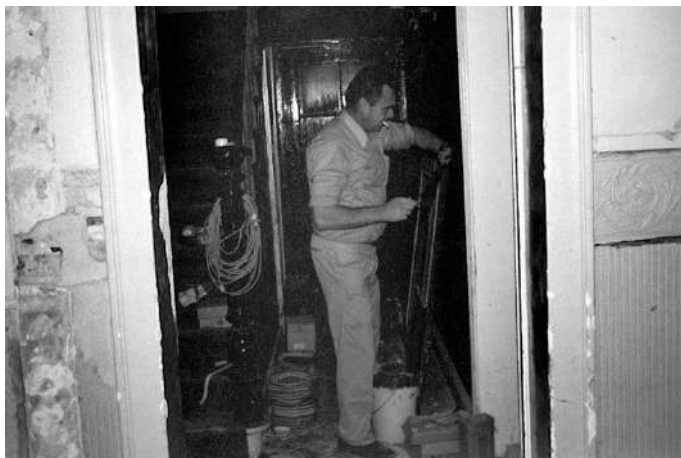
Figuur 14: Verbouwing: Maurice aan het werk
