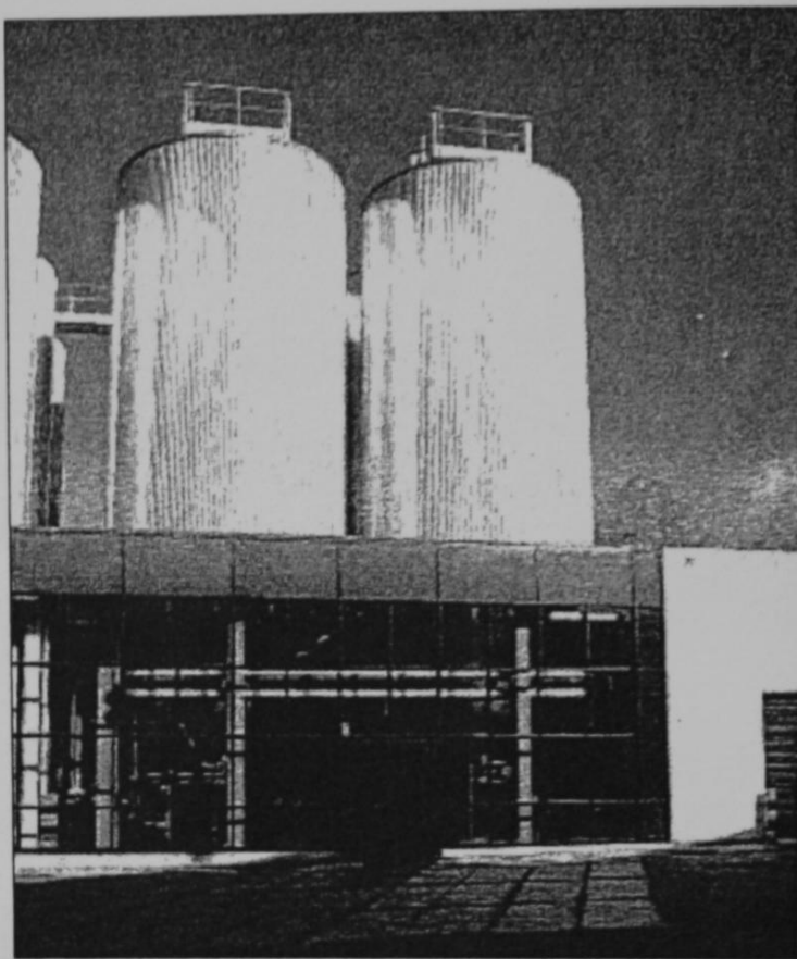
Buitenzicht van de cylindrokonische tanks.
