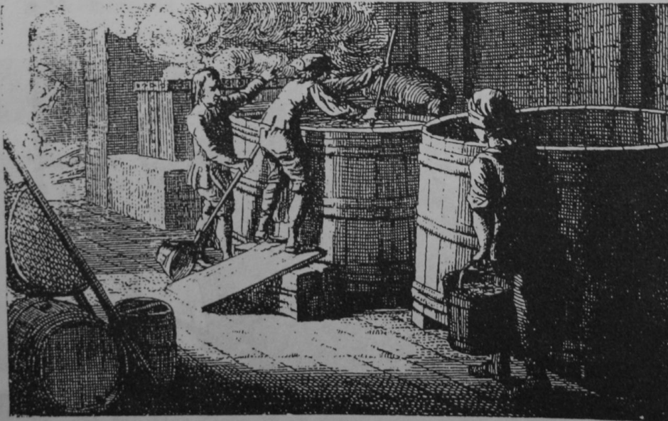
Berlijnse bierbrouwerij. (Achtttiende-eeuwse gravure). Midden: een man is het beslag aan het roeren; daarnaast staat een man met een jager (schepemmer); rechts: een meisje brengt 2 emmers met gemalen mout; links: rechthoekige kookketel; uiterst links: een man is brandhout aan het hakken.
